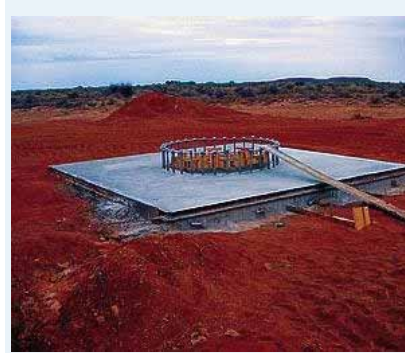
Die fondament van een van die eerste sewe radioteleskoop-skottels (KAT-7) wat deel sal wees van MeerKAT is reeds gele op die terrein buite Carnarvon. Dit is Suid-Afrika se padvinder-projek in die wedloop om die SKA (Square Kilometre Array) hier te huisves. Foto: VERSKAF
